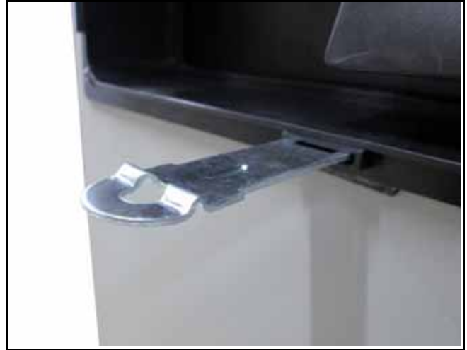
Рис. 3-6. Установка засова на смотровое окно
